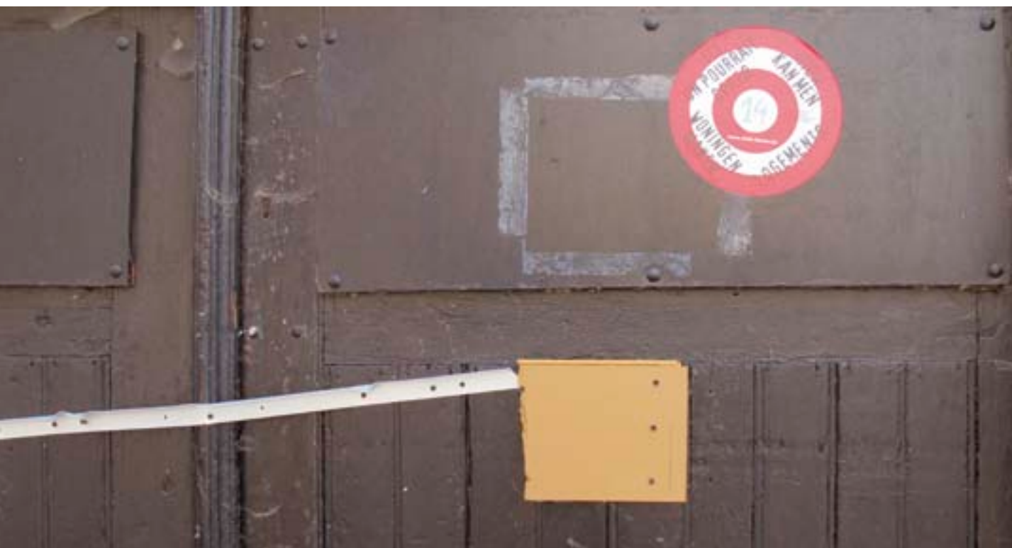
Op initiatief van de Brusselse Bond voor het Recht op Wonen werden leegstaande panden gemarkeerd met een 'leegstandsticker' zoals hier in de Otletstraat. Op de sticker staat "Hier kan men woningen maken". Zo wijst men de overheid op haar verantwoordelijkheid.
